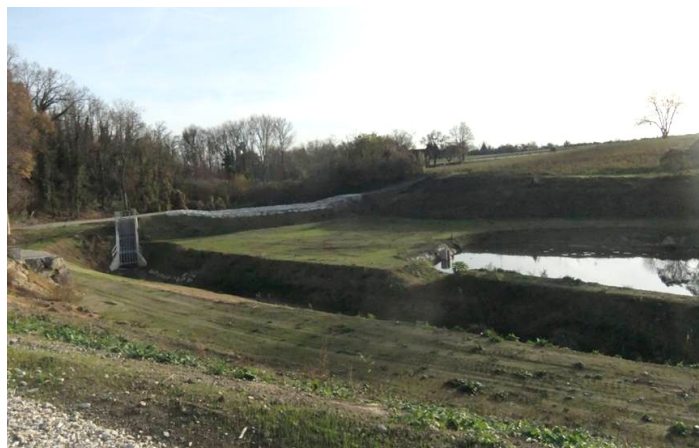
Hochwasserschutz Hippersdorf: Rückhaltebecken und Verbreiterung des Dorfbaches bieten Schutz vor Hochwasser HQ 100
